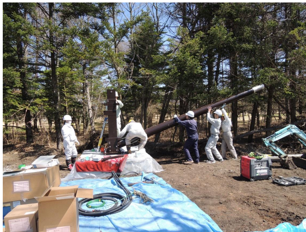
TLS200型センサー工事風景(軽井沢)
