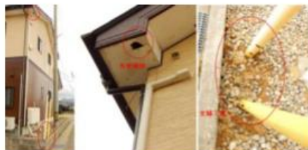
図12 砂利跳ね上りによる外壁損傷
