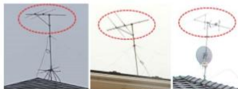
図13 TVアンテナ導波器の飛散
